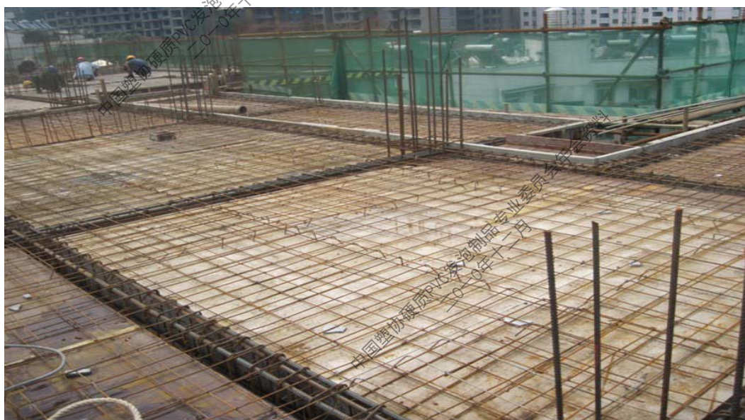
图5 PVC 模板施工效果
