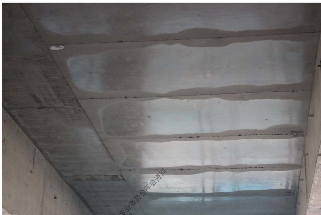
图8 PP模板拆模效果
