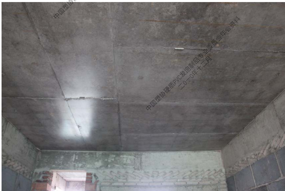
图 7 PVC 模板拆模后效果
